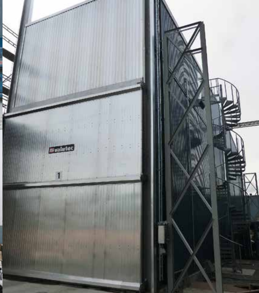
Kuva, jossa näkyy maassa rakennettu ja paikalleen nostettu seinä ja jossa tuodaan esiin nykyisen kuivaamon ja uuden alustan välinen tila.
